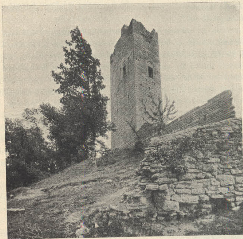
Fig. 1. — Torre de Saladeures
